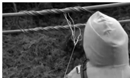
图1 输电线路进入等电位时的放电图
